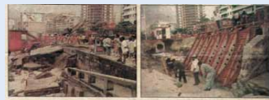
Muro do Posto 8 resiste a ressaca
