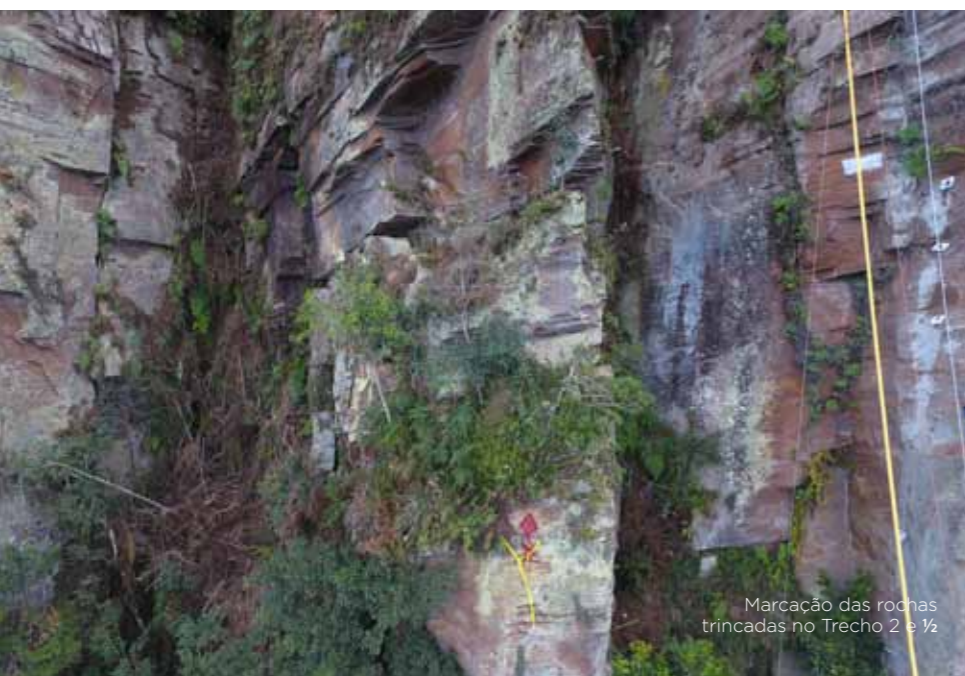
Atividades de perfuração no Trecho 5
