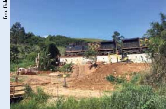
Vista geral da frente de obra em Três Rios
