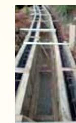
Construção da bacia de contenção
