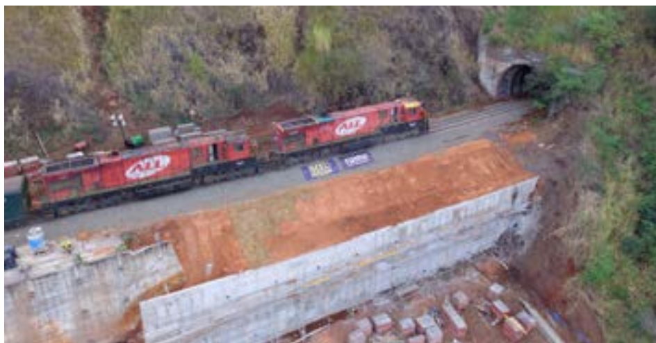
Imagens como a do trecho da Ferrovia Malha Oeste, em Botucatu (SP), da Obra 826 – RUMO e a do içamento noturno de uma viga de concreto sobre a Ponte do Rio Bacaxá entram para a história da SEEL
