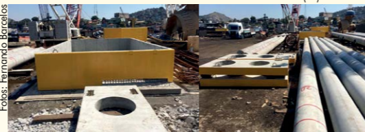
Passarelas, cascas dos dolphins e estacas prontas em frente da obra localizada em Niterói (RJ)
