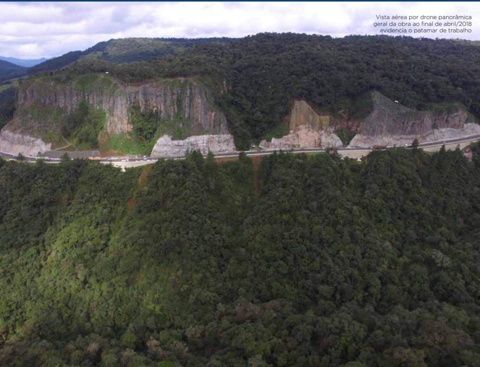
Vista aérea por drone panorâmica do trecho que mostra a Cortina 2 finalizada e taludes com ajustes finais na Rodovia BR-116
